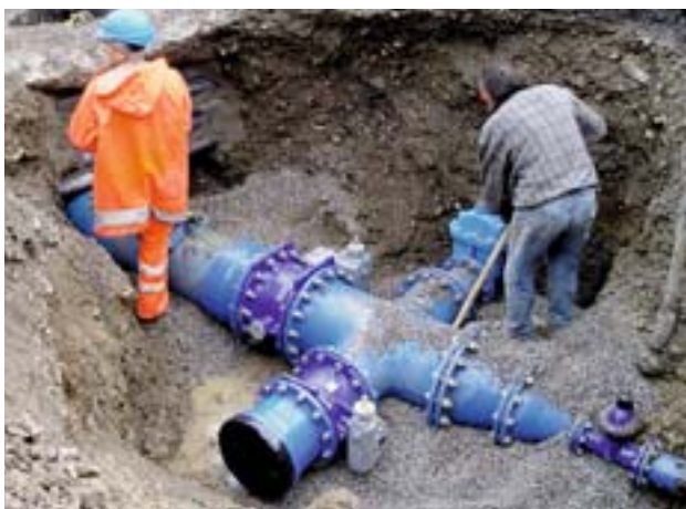
Bild 2: Einbau eines Schieberkreuzes im Bereich der „Hager“-Kreuzung
