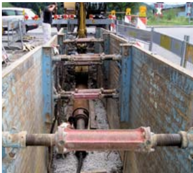
Bild 5: Rammbohrung von der Freibadstraße zur Querung des Stadionweges
