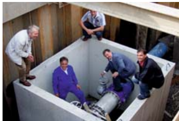
Bild 4: Baustellenbesichtigung mit (von links) Herrn Werkleiter Hägele, Herrn Sacirovski, Herrn Johne (beide Fa. Dobler), Herrn Bürgermeister Buhl und Herrn Schneider (Ing. Büro Schneider & Theisen) im Bereich des Schachtbauwerkes zur Spülung und Entleerung südlich des Wonnemar.
